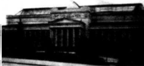
Музей изящных искусств в Москве. Общий вид. 1912 г. Архитектор Р.И. Клейн
