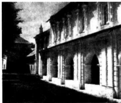
Трапезные палаты Ново-Иерусалимского монастыря, в которых ныне размещается экспозиция историко-архитектурного и художественного музея «Новый Иерусалим»
